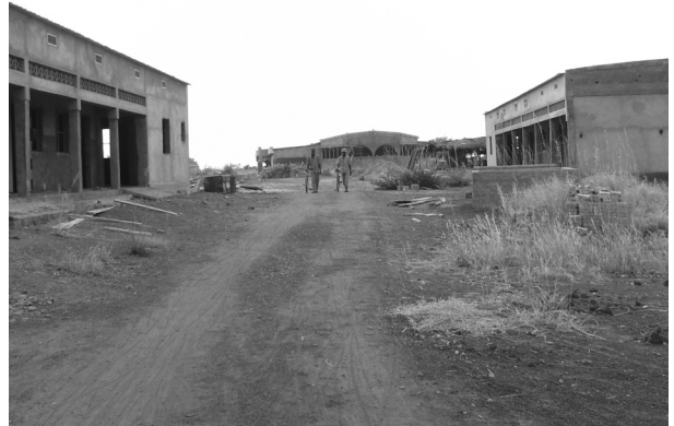
Le nouveau centre médical en construction
